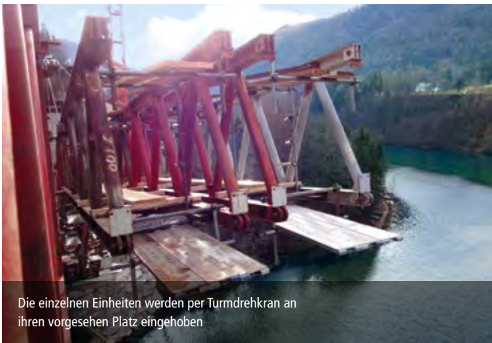
Die tonnenschweren Einheiten müssen präzise gesteuert werden, um passgenau montiert werden zu können
