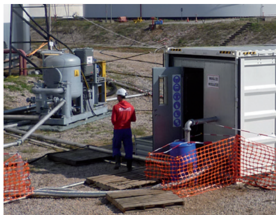
Die Jet-Washer werden aus den Anlagencontainern vollautomatisch über Touch-Panel gesteuert
