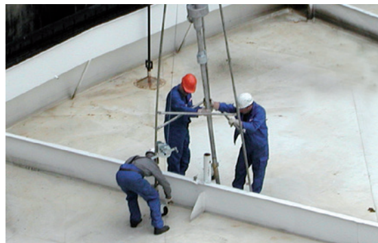
Die sogenannten Jet-Washer-Düsen werden durch Köcherrohre in den Tank eingelassen
