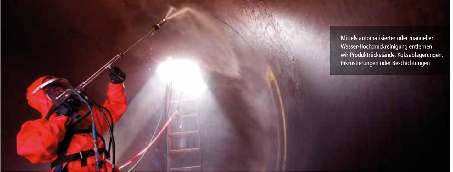
Mittels automatisierter oder manueller Wasser-Hochdruckreinigung entfernen wir Produktrückstände, Koksablagerungen, Inkrustierungen oder Beschichtungen
