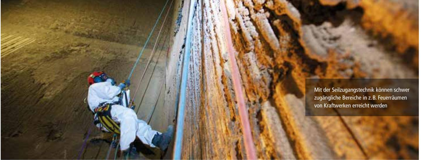
Mit der Seilzugangstechnik können schwer zugängliche Bereiche in z. B. Feuerräumen von Kraftwerken erreicht werden
