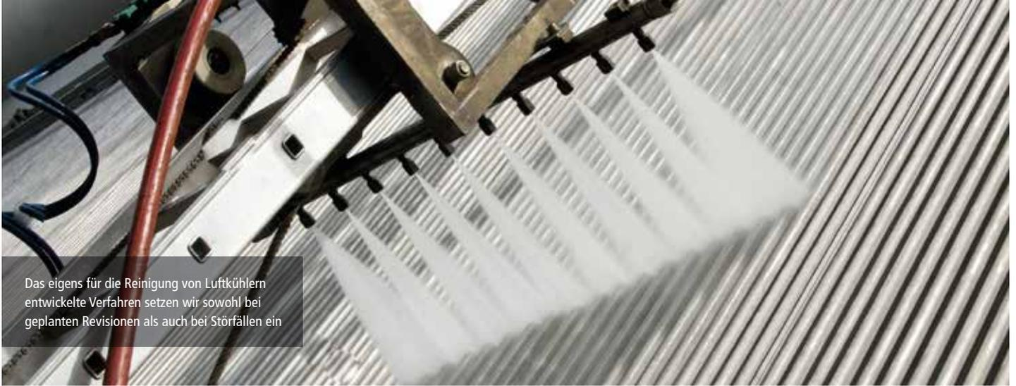
Das eigens für die Reinigung von Luftkühlern entwickelte Verfahren setzen wir sowohl bei geplanten Revisionen als auch bei Störfällen ein
