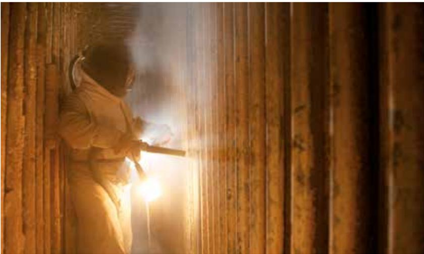
Unsere Verfahren: Sandstrahlen, Trockeneisstrahlen (CO<sub>2</sub>), Vakuumstrahlen oder Wasserhochdrucktechnik
