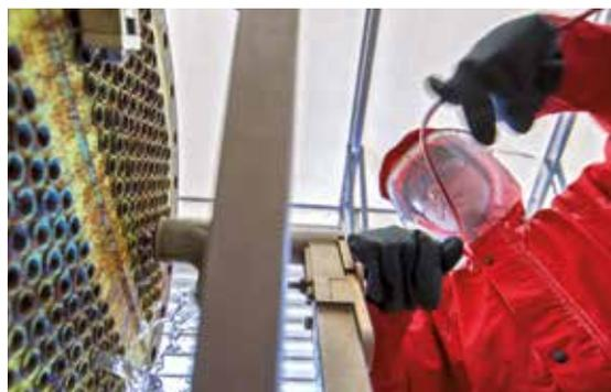
Mittels Wasserstrahl-Höchstdruckverfahren entfernen wir hartnäckigste Koksablagerungen an Wärmetauschern
